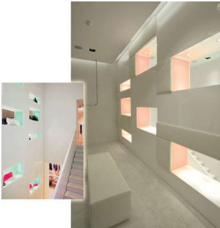
Рис. 10, 11. Светодиоды, установленные в ниши и позади матовых диффузоров
