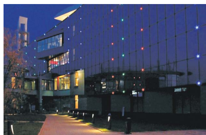
Рис. 6. Освещение стеклянного фасада и прилегающей территории ТРЦ «Маяк»
