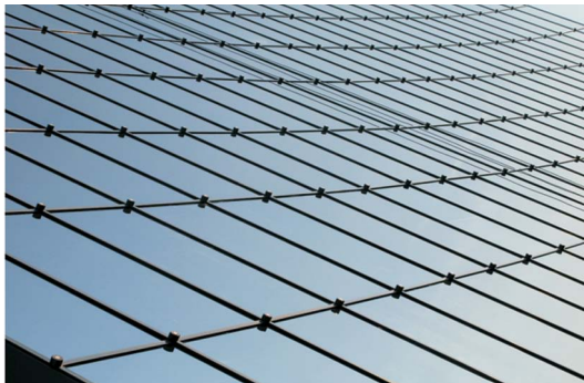
Рис. 4. 400 точечных светодиодных светильников смонтированы в узлах
